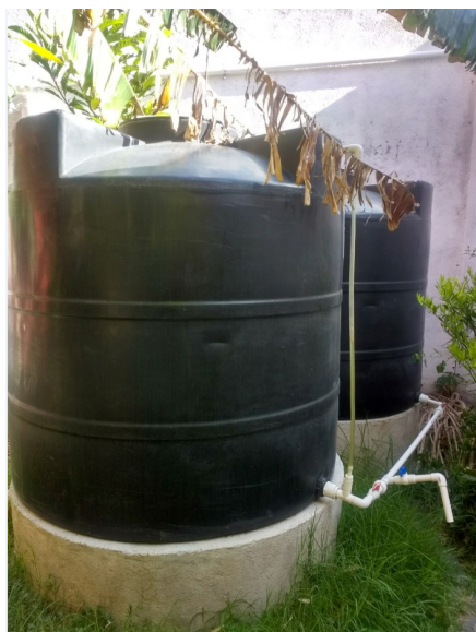
Modelo del Sistema de Captación de Lluvia instalado en las oficinas de Caminos de Agua con capacidad de 5,000 litros.
